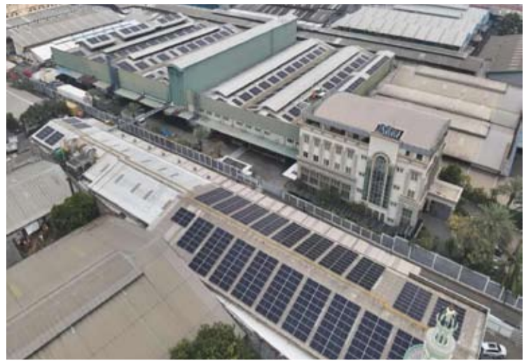
Garuda Metalindo 公司(BOLT)厂房。
